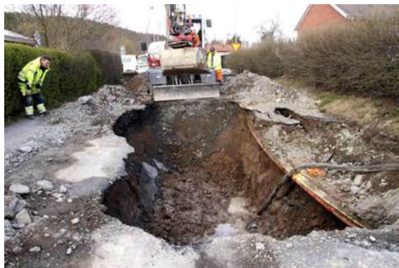
Reparation av vattenläcka pågår. Bildkälla: VA-Fakta
